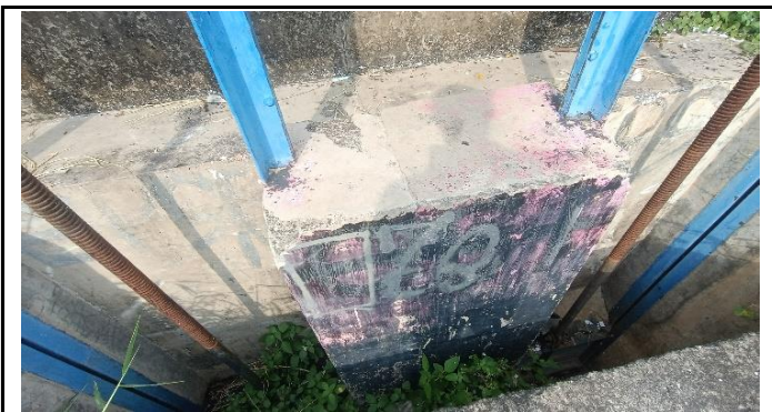
KONDISI BANGUNAN PINTU AIR
