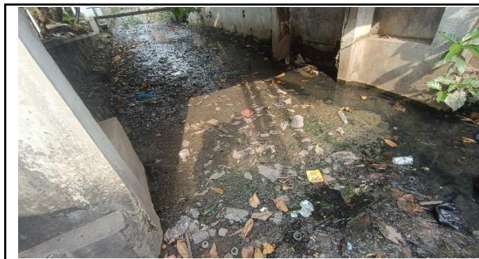
PENDANGKALAN PADA ALIRAN SUNGAI
