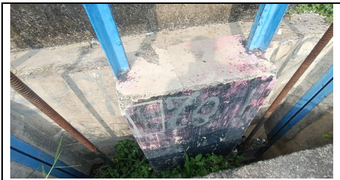
KONDISI BANGUNAN PINTU AIR
