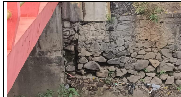
BANGUNAN PENGAMAN TEBING PECAH
