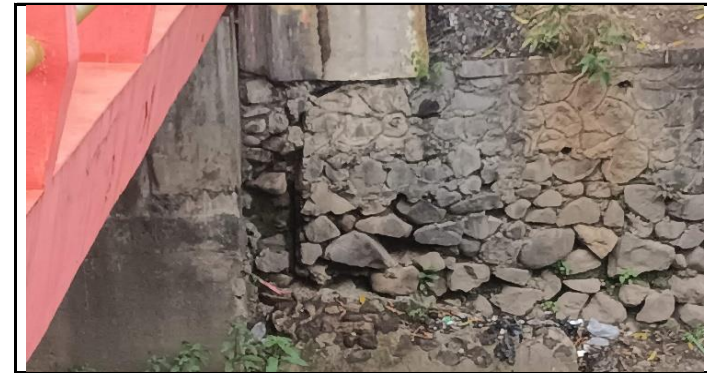
BANGUNAN PENGAMAN TEBING PECAH
