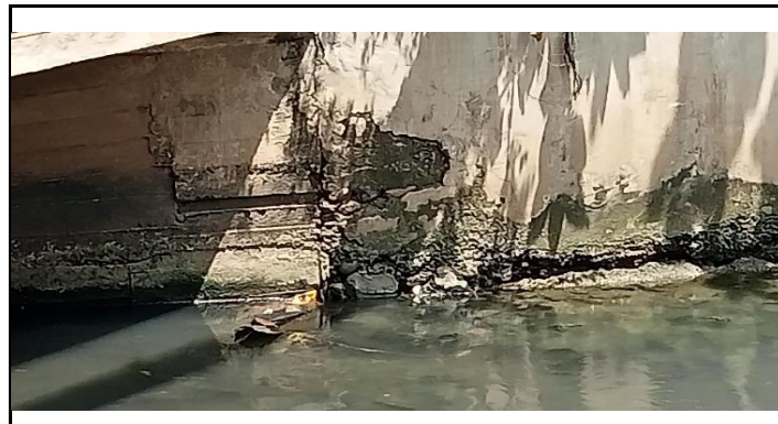
KONDISI BANGUNAN BAWAH
