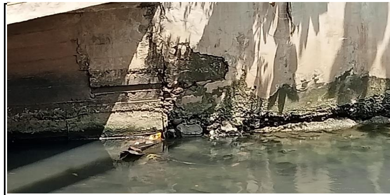
KONDISI BANGUNAN BAWAH
