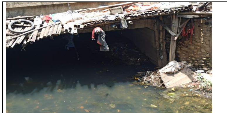
KONDISI BANGUNAN BAWAH
