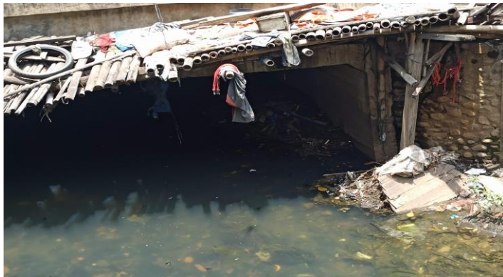
KONDISI BANGUNAN BAWAH
