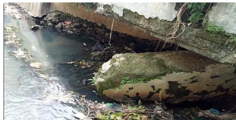
KONDISI BANGUNAN BAWAH
