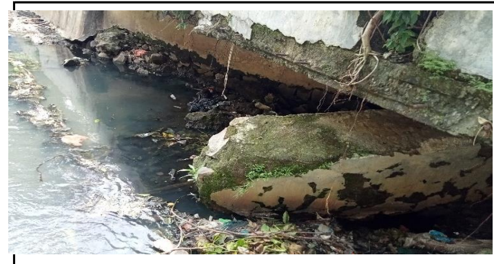
KONDISI BANGUNAN BAWAH
