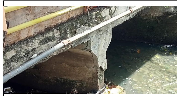
KONDISI BANGUNAN BAWAH
