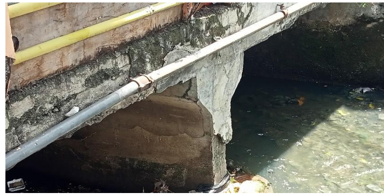
KONDISI BANGUNAN BAWAH
