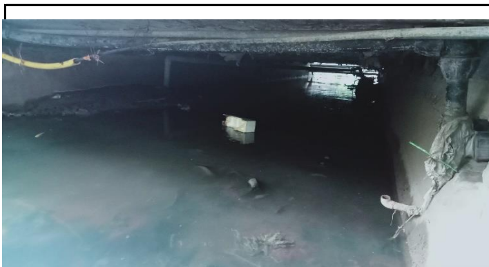
KONDISI BANGUNAN BAWAH
