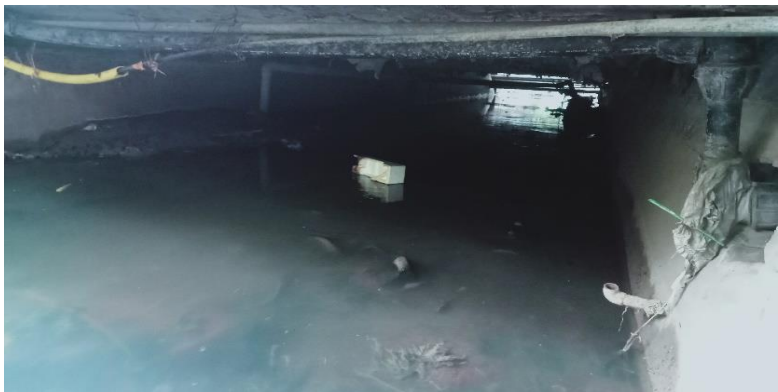
KONDISI BANGUNAN BAWAH
