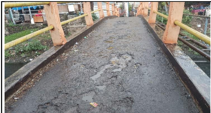
LAPISAN PERMUKAAN LANTAI BERLUBANG
