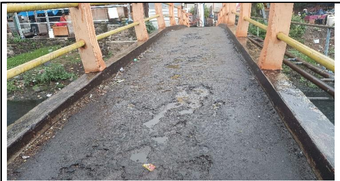
LAPISAN PERMUKAAN LANTAI BERLUBANG
