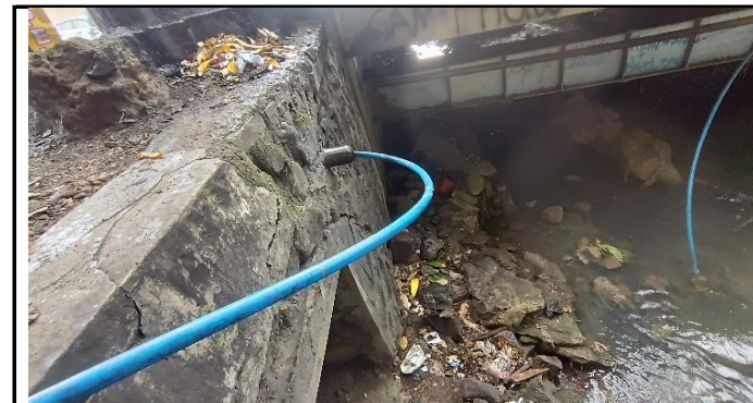
KONDISI BANGUNAN BAWAH
