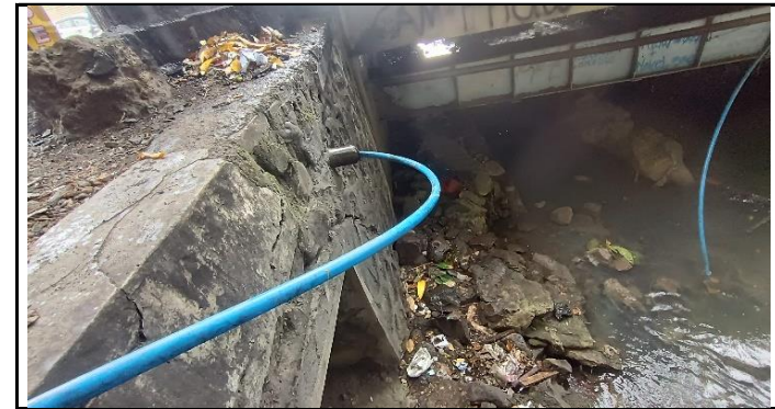
KONDISI BANGUNAN BAWAH
