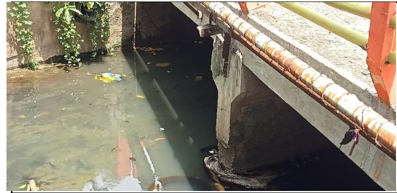
KONDISI BANGUNAN BAWAH
