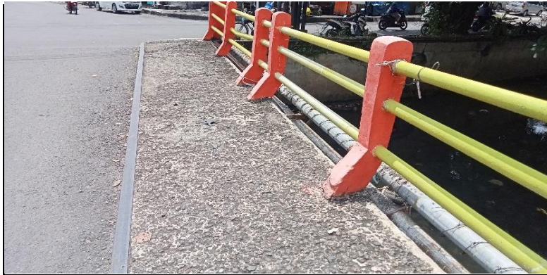
KONDISI SANDARAN DAN TROTOAR
