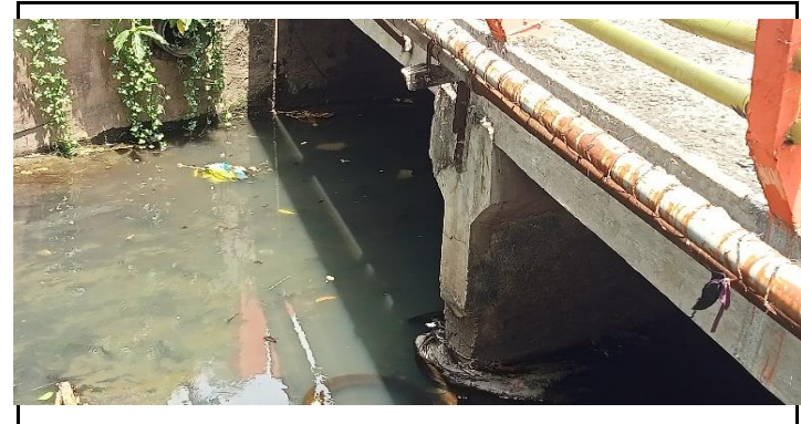
KONDISI BANGUNAN BAWAH
