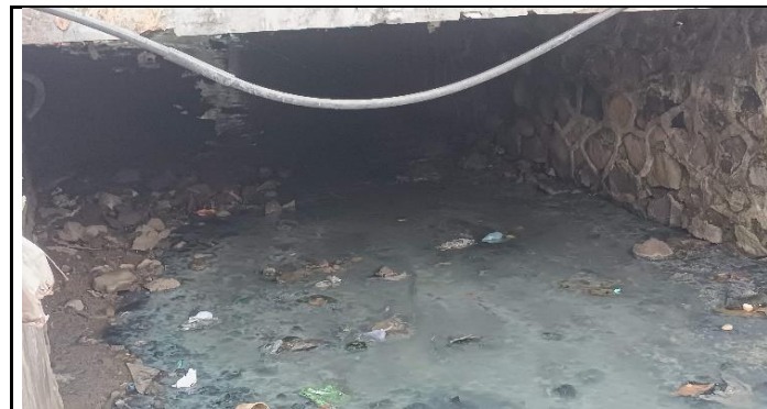
KONDISI BANGUNAN BAWAH
